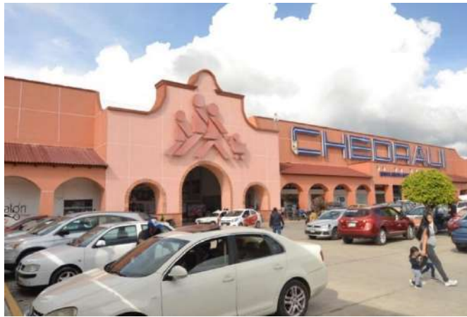
Figura 5 Plaza comercial “San Cristóbal”
